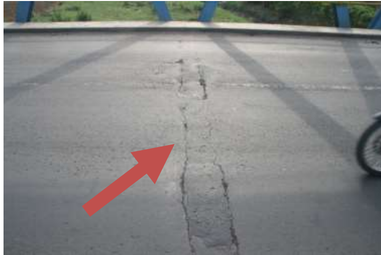
Gambar 11. Retak daerah sekitar sambungan melintang
