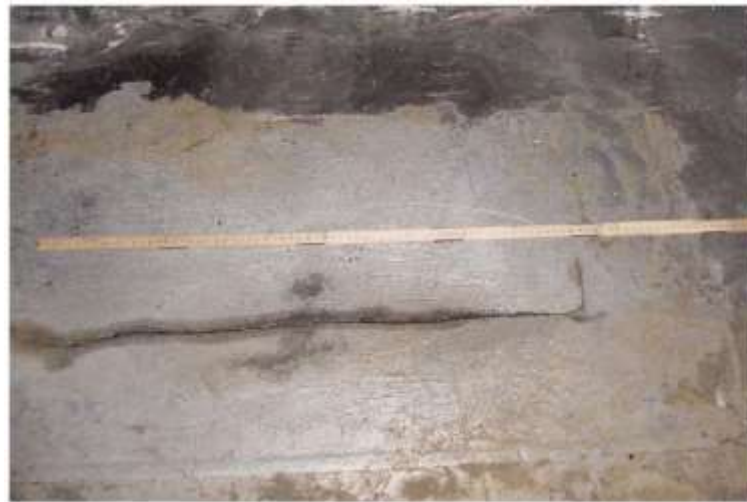
Gambar 33. Retak pada pelat dek
