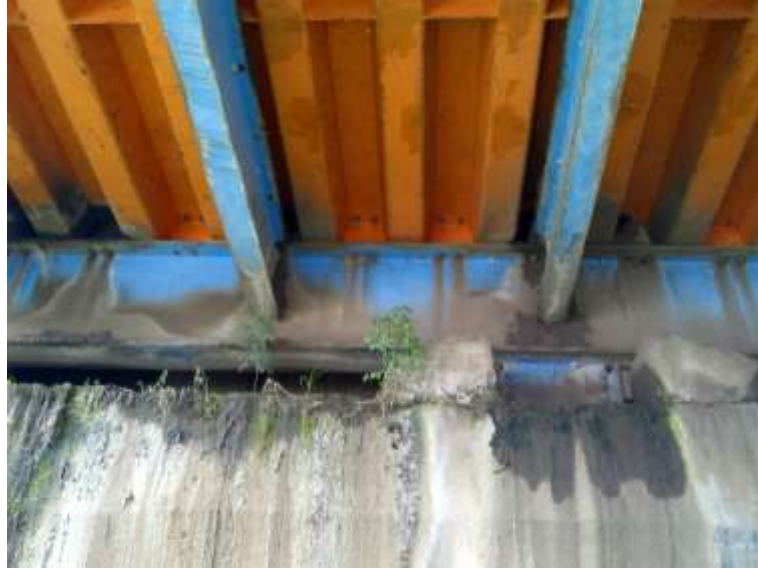
Gambar 18. Limpasan air dan kotoran di bawah siar muai
