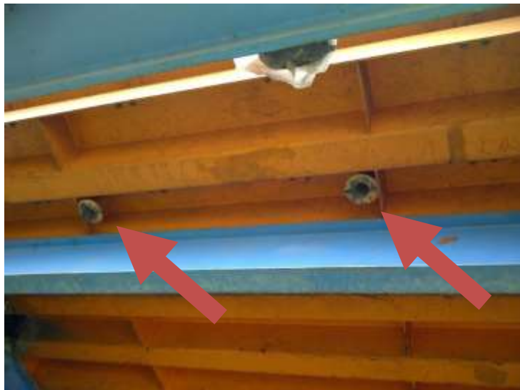
Gambar 8. Kehilangan bagian pipa logam
