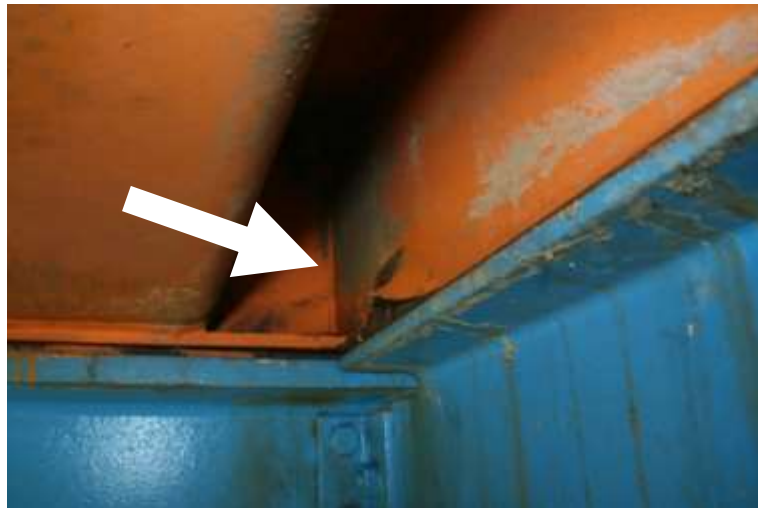
Gambar 19. Daerah-daerah yang mungkin terlewat selama pengecatan
