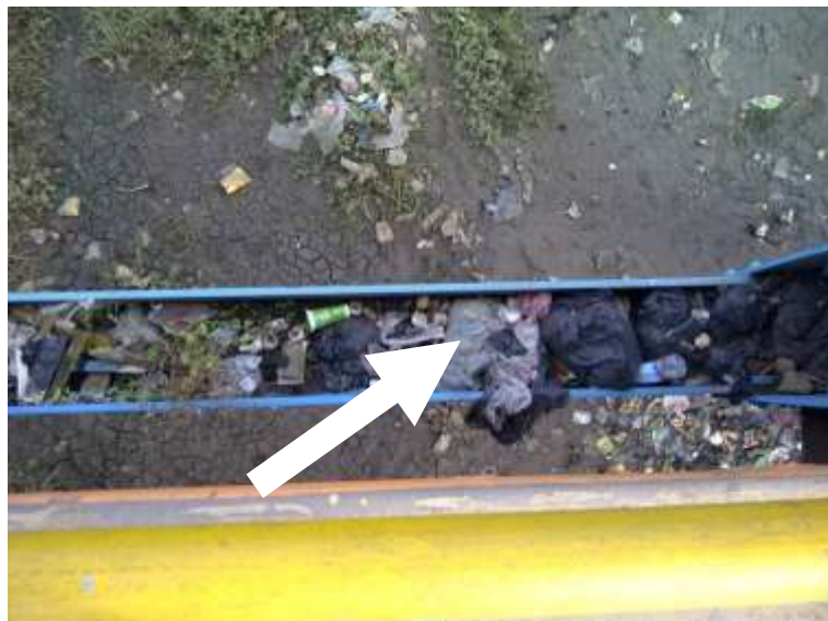
Gambar 23. Tumpukan sampah pada batang bawah rangka baja
