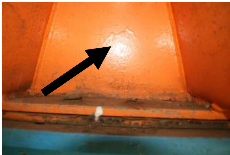
Gambar 17. Lapisan cat yang terlalu tebal
