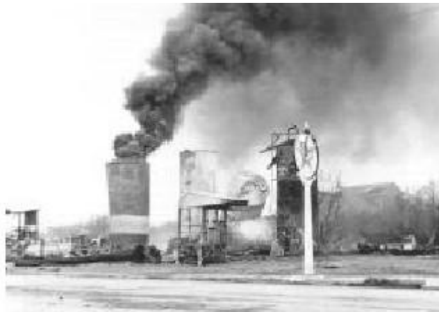
Gambar 38 - Kebakaran tangki minyak tanah akibat kerusakan tsunami tahun 1964 pada jalan raya 101 dekat Crescent City, California. Sumber: NTHMP 2001
