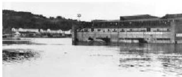
Gambar 37 - Genangan akibat tsunami di saluran stasiun Kodiak Naval akibat tsunami tahun 1964, sumber: NTHMP 2001
