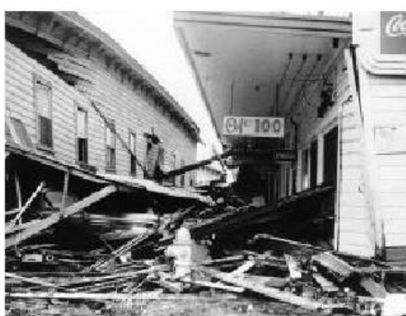
a) Kerusakan gedung di Hilo, Hawaii karena tsunami tahun 1946. Sumber: NTHMP 2001
