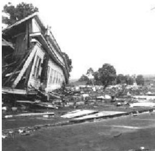
Gambar 28 - Kerusakan gedung di Hilo, Hawaii karena tsunami 1960 meskipun tersedia material dan teknik rekayasa yang dapat diterapkan untuk menahan gaya-gaya tsunami dan genangan, dalam kasus tsunami yang hebat, hal tersebut hanya mengurangi kerugian tetapi tidak dapat mencegah kerusakan yang hebat, sumber: NTHMP 2001
