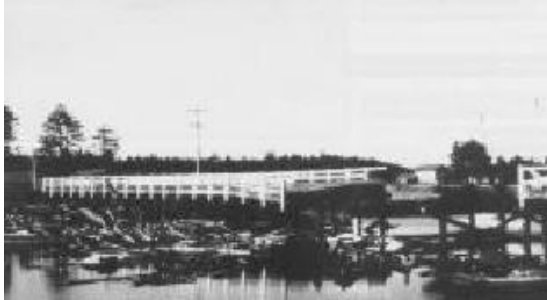
a) Kerusakan pada jembatan layang jalan raya 109 negara bagian Washington melewati sungai Copalis dari tsunami tahun 1964. Sumber: NTHMP 2001
