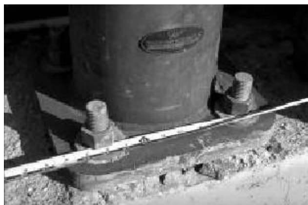
Gambar 30 - Baut angker. Peralatan untuk menahan guncangan gempa, seperti angker dan bangunan rangka, dapat juga mengurangi kerusakan akibat tsunami, sumber: NTHMP 2001 .
