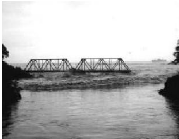
Gambar 35 - Perlemahan akibat gelombang melalui jembatan jalan kereta api pada sungai Wailuku di Hilo, Hawaii pada waktu tsunami tahun 1946, sumber: NTHMP 2001
