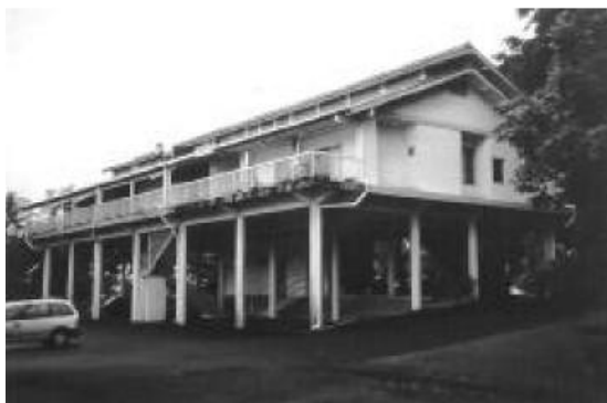
Gambar 25 - Bangunan restoran di Hilo, Hawaii. Bangunan tingkat bawah didesain untuk memperbolehkan gelombang melewatinya. Sumber: NTHMP 2001
