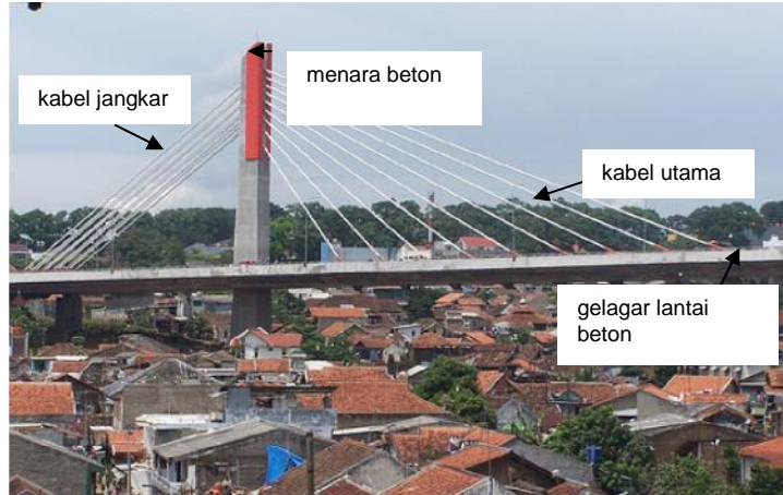
Gambar 2 - Jembatan Pasupati, bentang utama 106 m dan total 161 m, menara dan gelagar dari beton, prinsip kabel kaku
