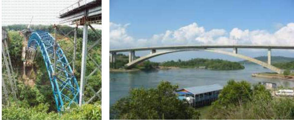
Gambar 2 . Jembatan pelengkung murni/kaku beton bertulang komposit Barelang, bentang utama L = 245 m
