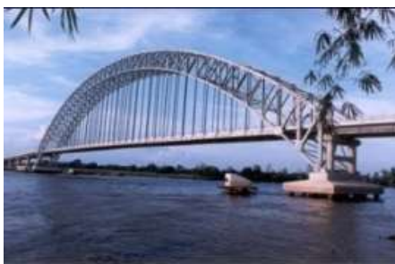
Jembatan Martadipura (200 m)
