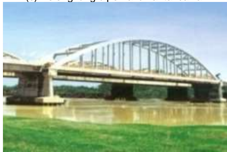
Jembatan Cindaga (90 m)
