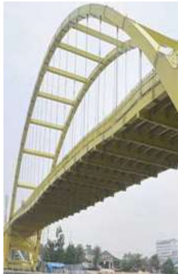
Gambar 5 (b) Hanger untaian / strand di Jembatan Siak III
