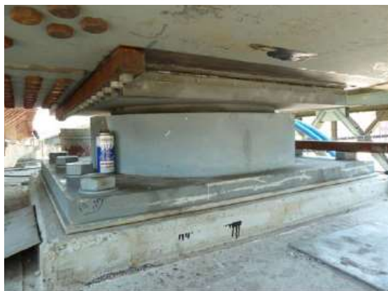
Gambar 8. Perletakan pada pelengkung diperkaku
