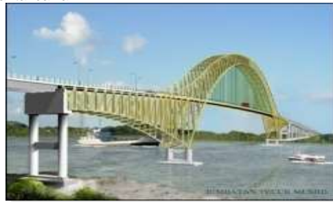
Jembatan Teluk Masjid (250 m)
