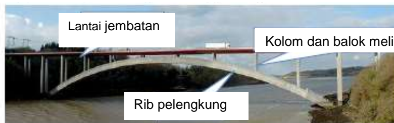
(b) Bentang utama 180m ( rib : boks multi sel)
