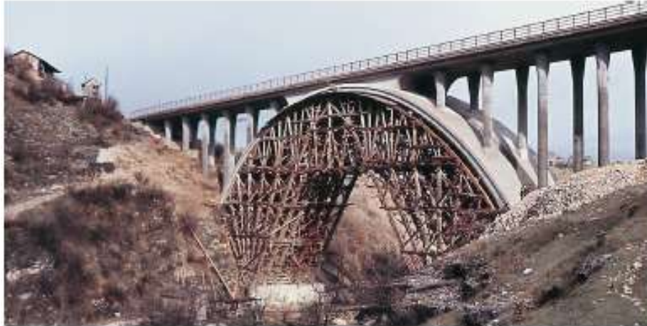
Gambar 17. Cara pertama : Pengecoran diatas perancah
