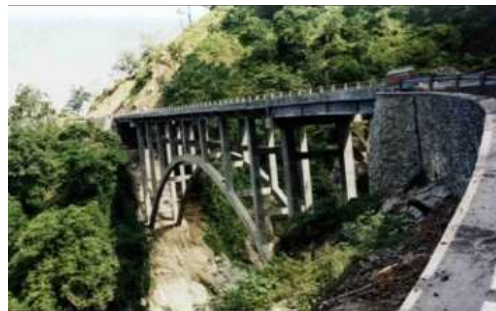
(a) Bentang utama 80m ( rib : balok persegi)
