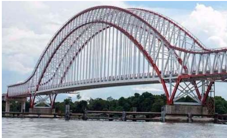
Gambar 5 a. Hanger batang profil baja (berupa pendel) di Jembatan Tayan
