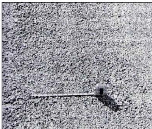
c. Pelepasan butir (raveling)
