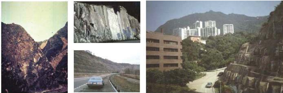
Gambar 27 Formasi batuan yang menunjukkan pelipatan, lereng galian, bidang, dan cara-cara stabilisasi
