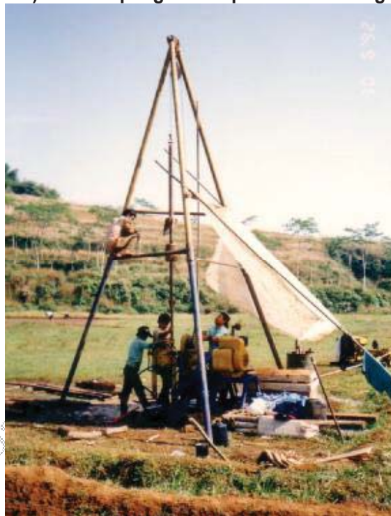
b) Pengeboran inti di as bendung secara lebih rinci
