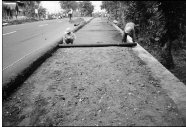
**Gambar 25 Membran geosintetik**
