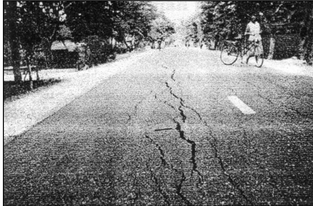
**Gambar 1 Retakan memanjang pada tepi perkerasan jalan**
