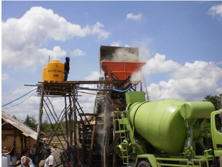
Gambar A.10 - Pembuatan material ringan mortar-busa (Sumber : Pusjatan. 2009)
