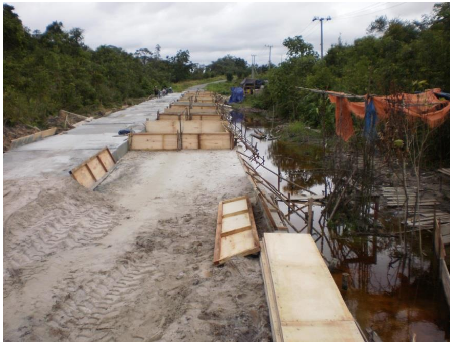
Gambar A.13 - Pemasangan bekisting (Sumber : Pusjatan. 2009)
