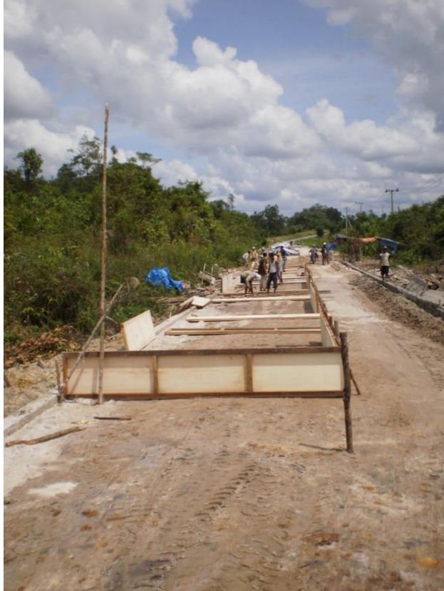
Gambar A.12 - Pembuatan bekisting (Sumber : Pusjatan. 2009)
