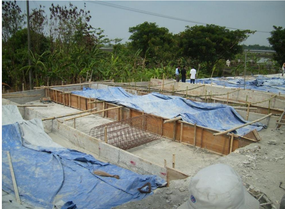
Gambar A.14 - Pemasangan anyaman baja (jika dibutuhkan)
