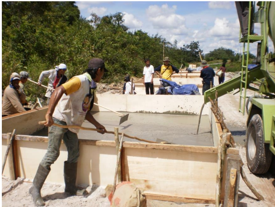
Gambar A.24 - Perataan material ringan mortar-busa (Pusjatan. 2009)
