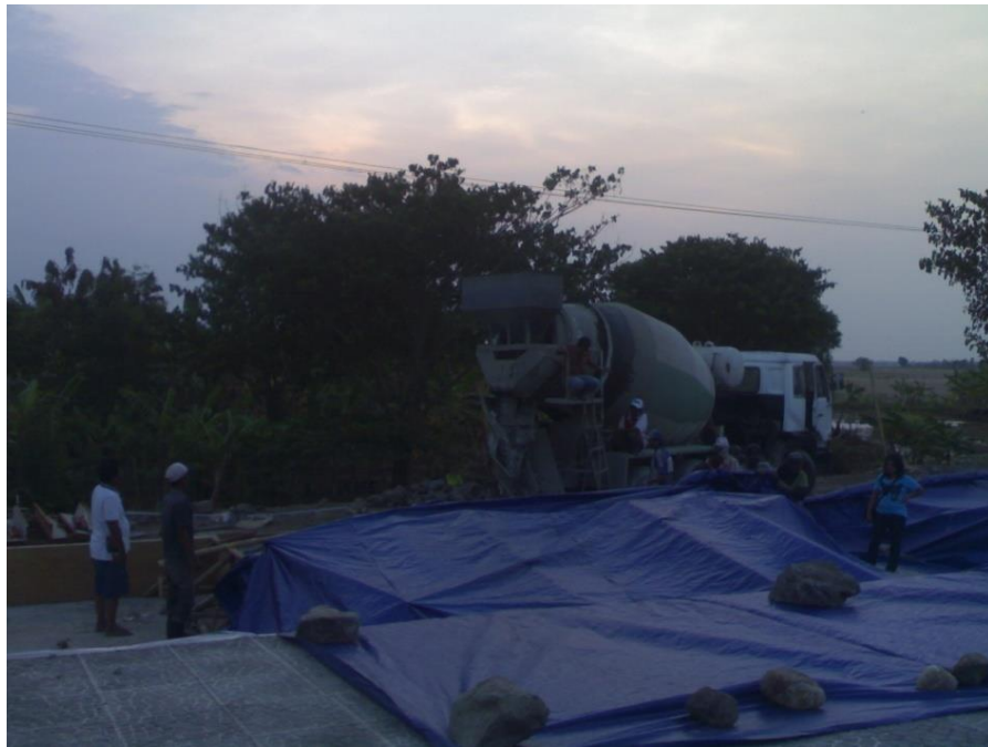
Gambar A.25 - Perawatan (Pusjatan. 2009)
