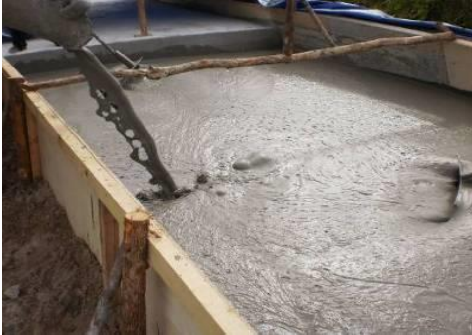
Gambar A.21 - Penghamparan material ringan mortar-busa (Sumber : Pusjatan.pu.go.id, 2012)
