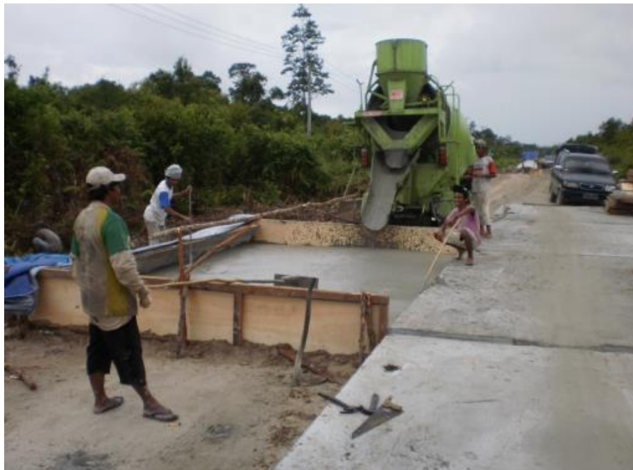
Gambar A.22 - Penghamparan mortar-busa (Sumber : pusjatan.pu.go.id, 2012)
