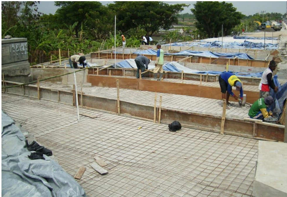
Gambar A.15 - Pemasangan anyaman baja (jika dibutuhkan) (Sumber : Pusjatan. 2009)
