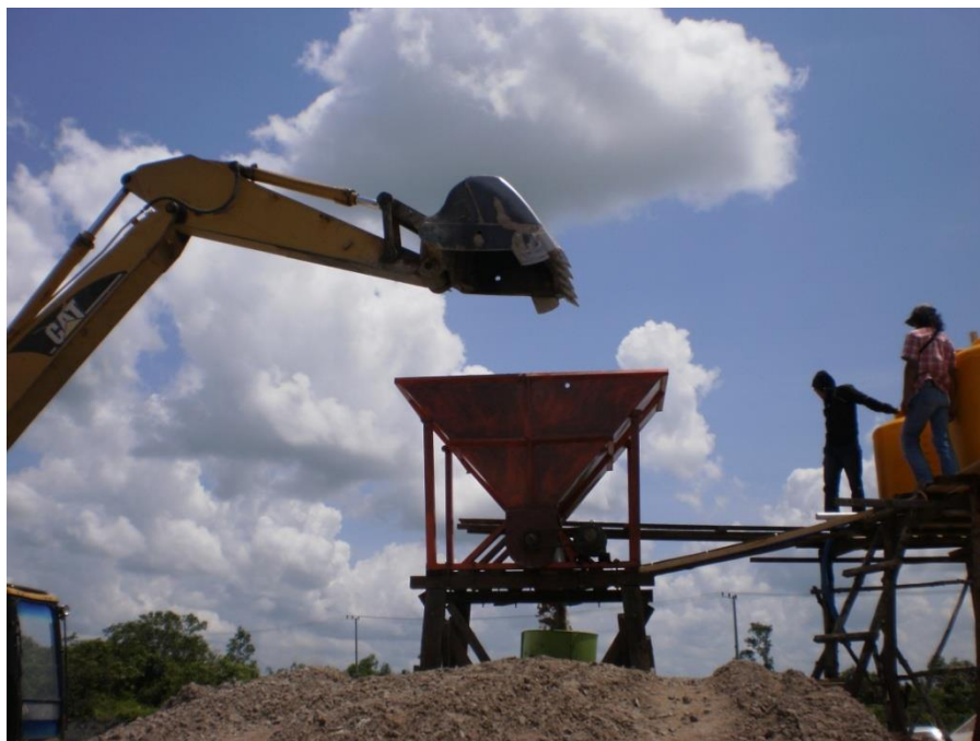
Gambar A.9 - Pembuatan material ringan mortar-busa (Sumber : Pusjatan. 2009)
