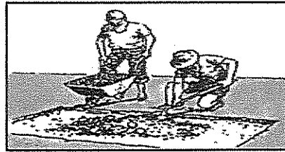
3c - Pengangkutan bahan bongkaran lapis permukaan beraspal
