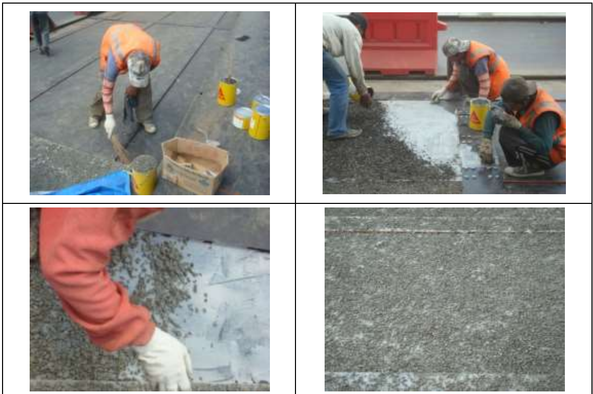
Gambar A.4 - Hasil pemasangan pelat ortotropik baja
