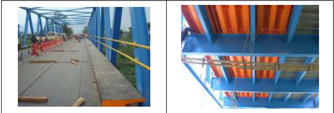
Gambar A.4 - Hasil pemasangan pelat ortotropik baja
