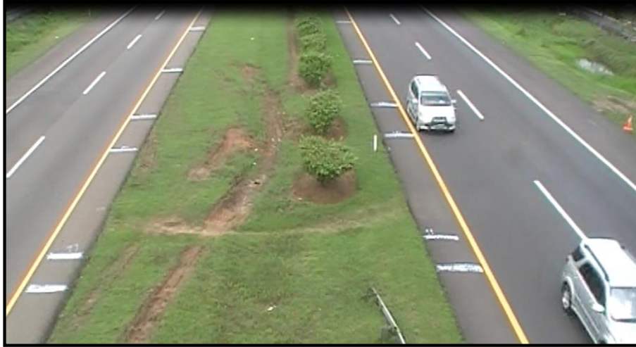
Gambar 6-25. Tipikal JBH 4/2-T dengan median direndahkan, Jalan Tol Padaleunyi (2012)
