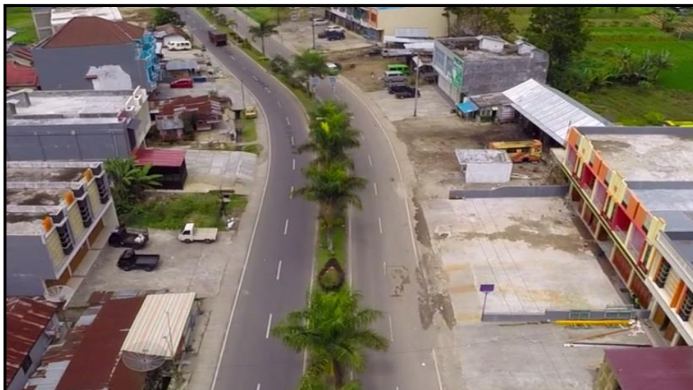
Gambar 6-18. Tipikal jalan 4/2-T, arteri perkotaan (Bukit Tinggi Sumbar, 2014)
