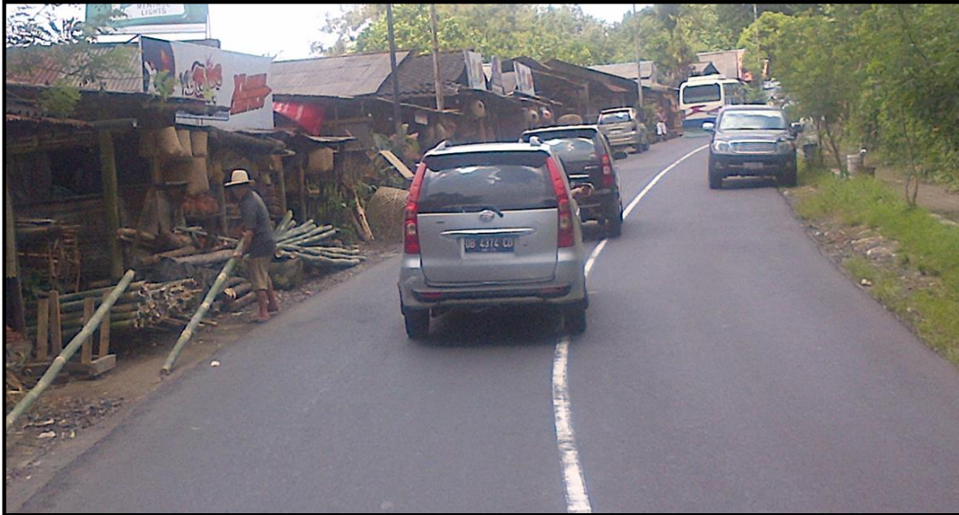
Gambar 6-10. Tipikal jalan 2/2-TT eksisting, batas Menado-Tomohon, Sulut, 2014
