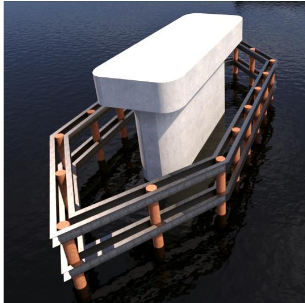
Gambar 8.12- Fender sebagai pengaman pilar jembatan
