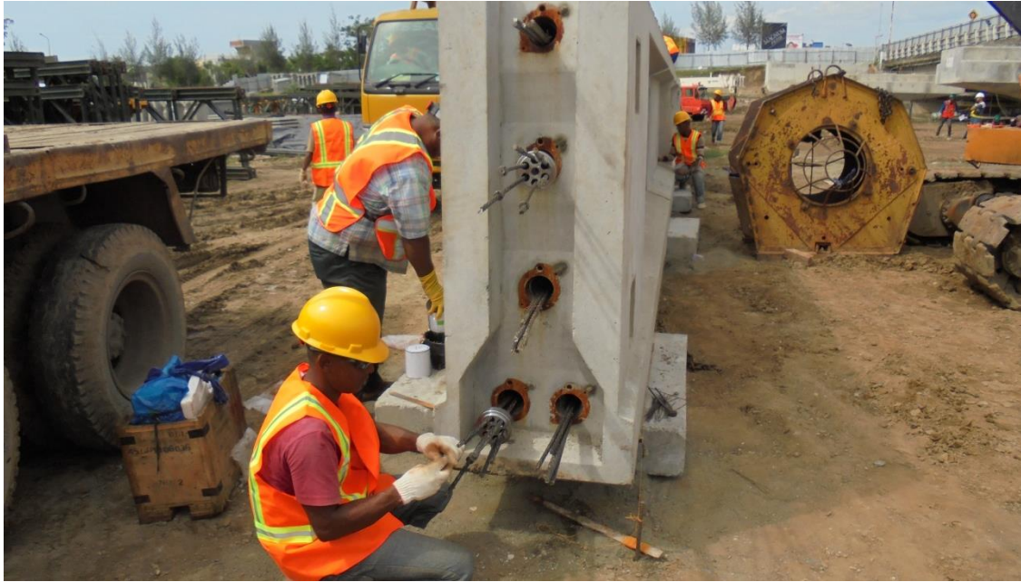
Gambar 6.19 - Pemasangan angkur
