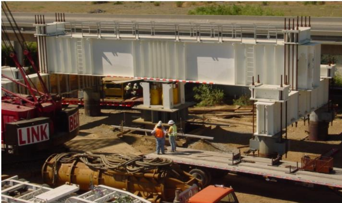
Gambar 4.40- Uji pembebanan statis dengan metode reaction pile (FHWA, 2016)
