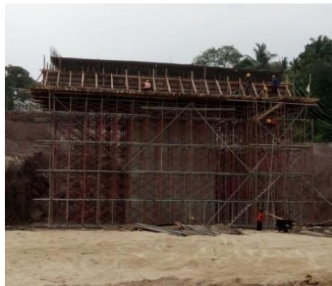
Gambar 5.29 - Pekerjaan bekisting kepala pilar
