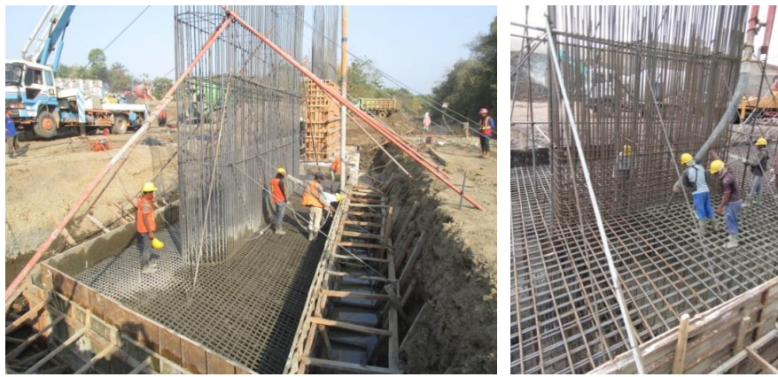
Gambar 5.23 - Pekerjaan pengecoran poer ( pile cap )
