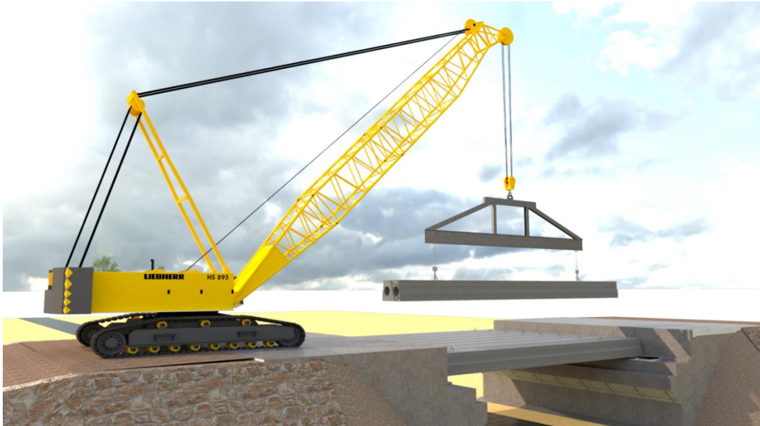
Gambar 6.42- Proses Erection dengan satu Crane angkat
