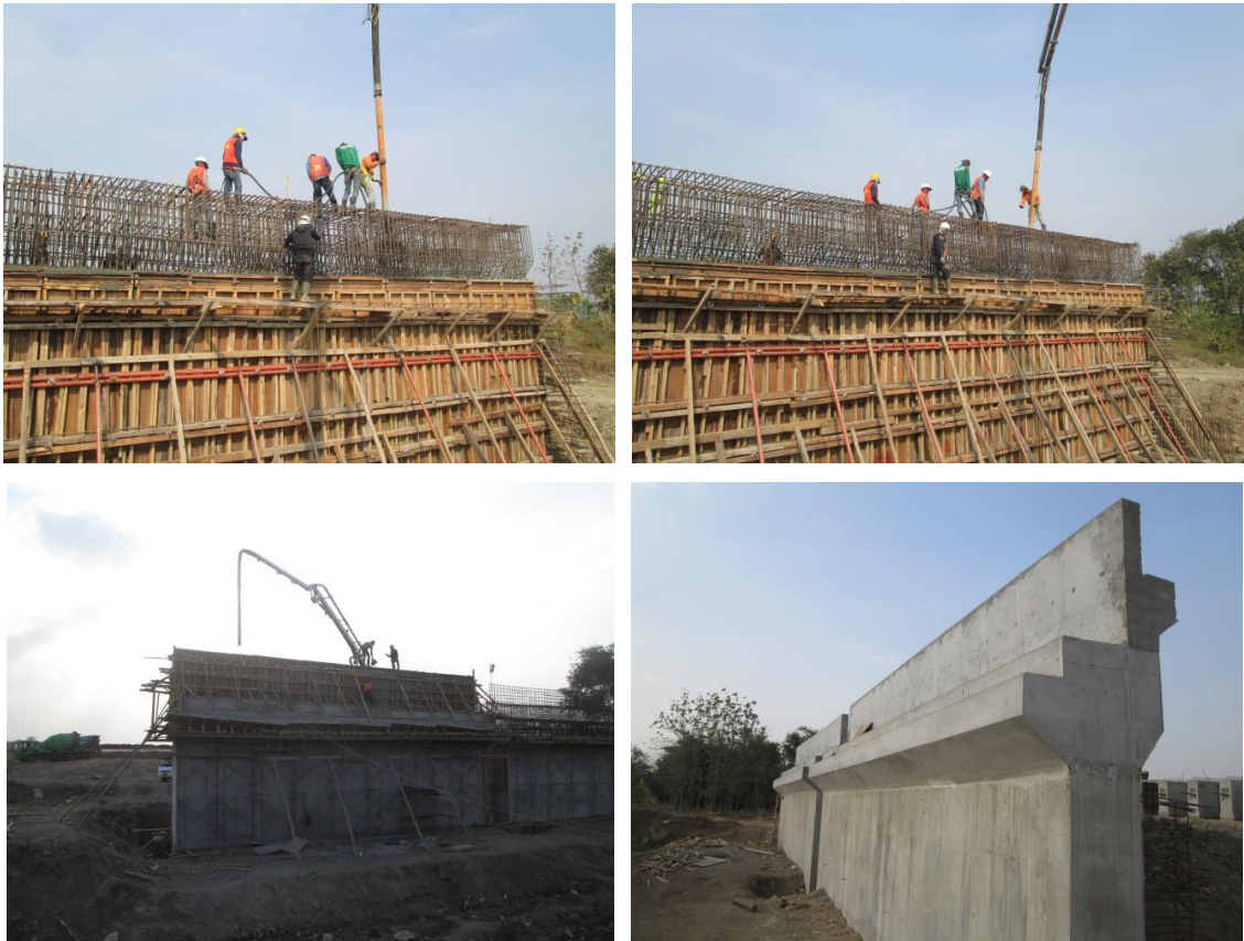
Gambar 5.14 - Pekerjaan pengecoran badan abutment
