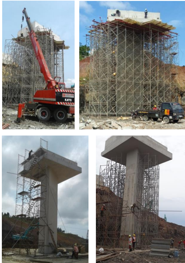
Gambar 5.31 - Pekerjaan akhir kepala pilar
