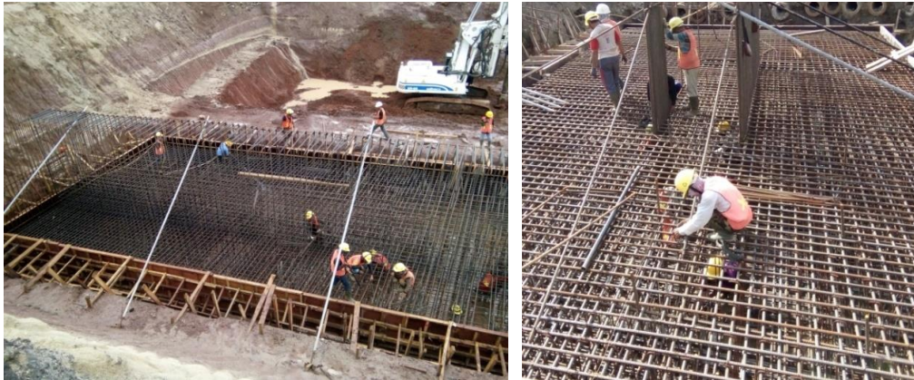
Gambar 5.22 - Pekerjaan penulangan poer ( pile cap )
