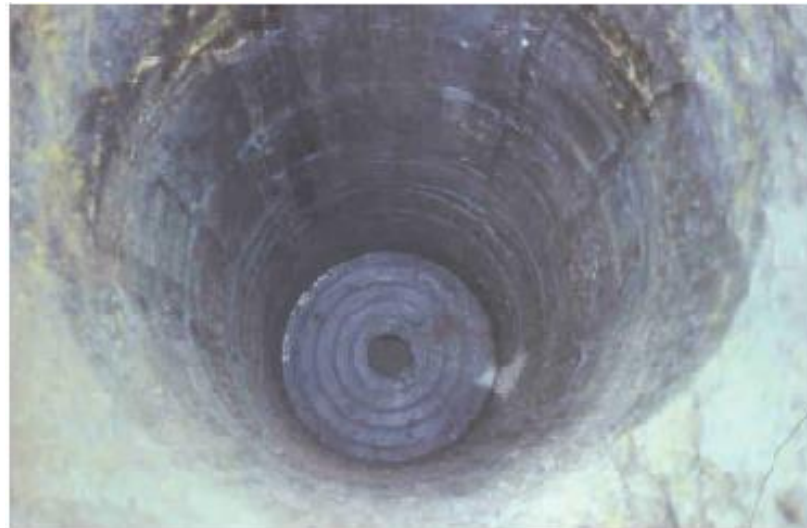
Gambar 4.29 - Lubang hasil galian menggunakan metode kering
