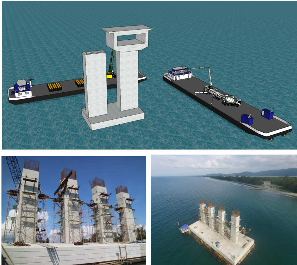
Gambar 5.41 - Pekerjaan badan pilar
