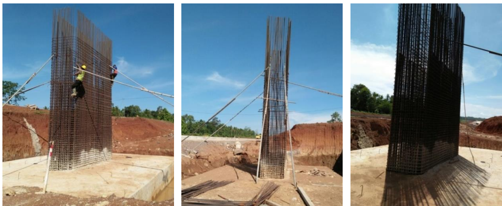
Gambar 5.25 - Pekerjaan penulangan pier kolom
