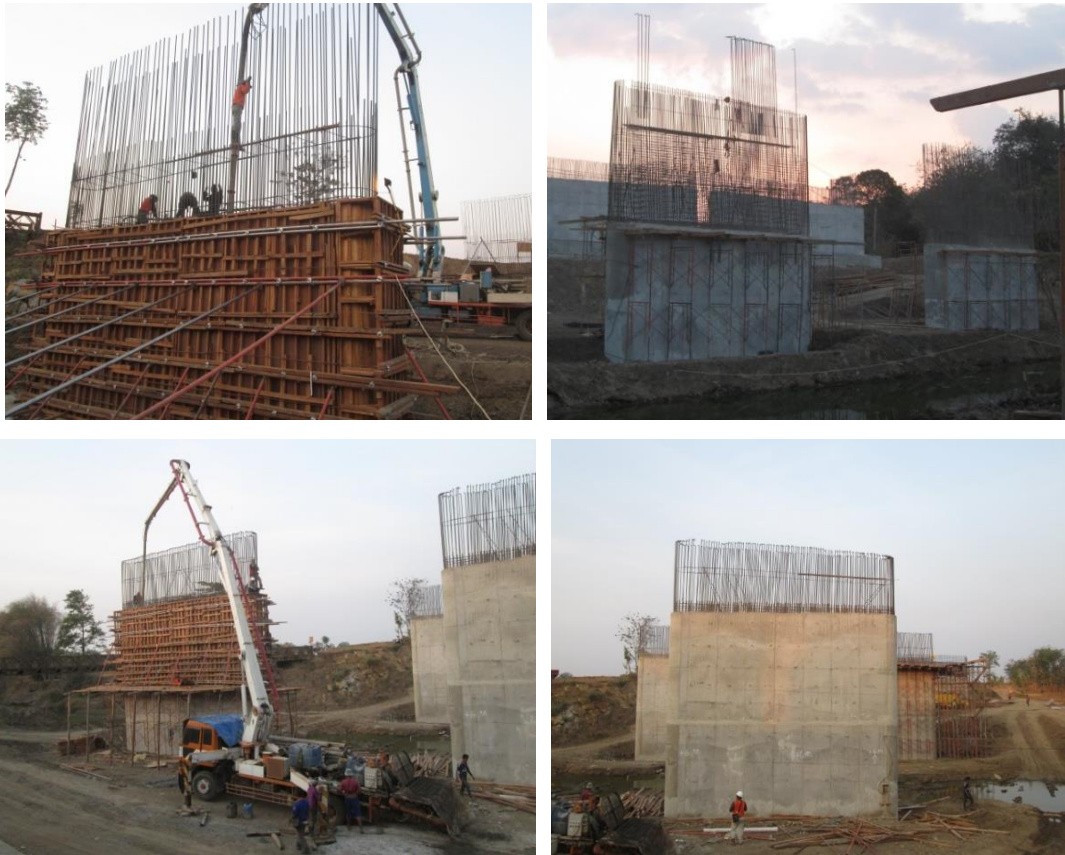
Gambar 5.27 - Pekerjaan pengecoran poer ( pile cap )
