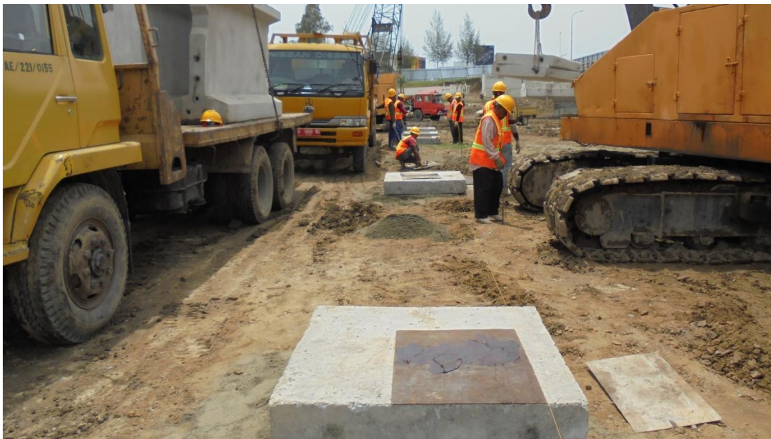
Gambar 6.16 - Landasan Stressing atau lantai kerja
