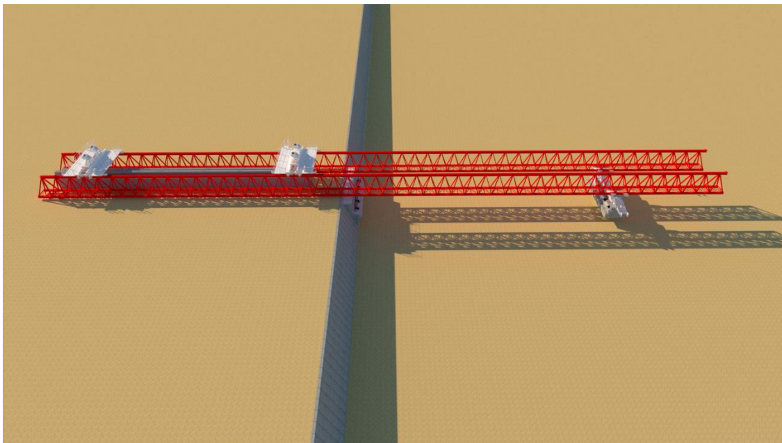
Gambar 6.56 - Proses Erection dengan Double Launcher
