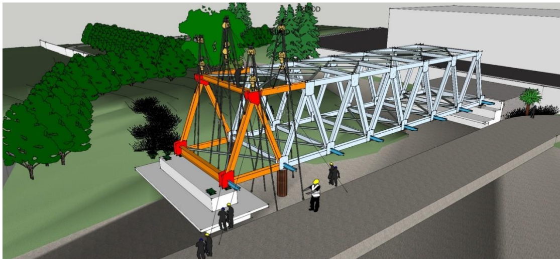
Gambar 6.73 - Rangka baja mencapai satu span penuh
