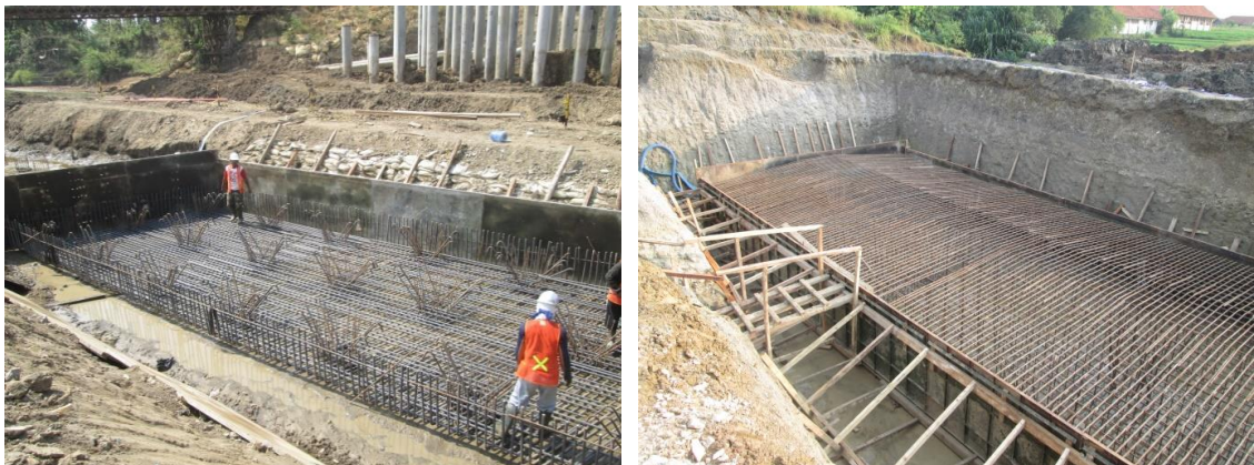
Gambar 5.9 - Pekerjaan bekisting footing kepala jembatan
