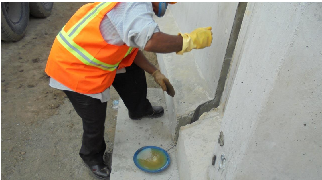
Gambar 6.20 - Pengolesan epoxy
