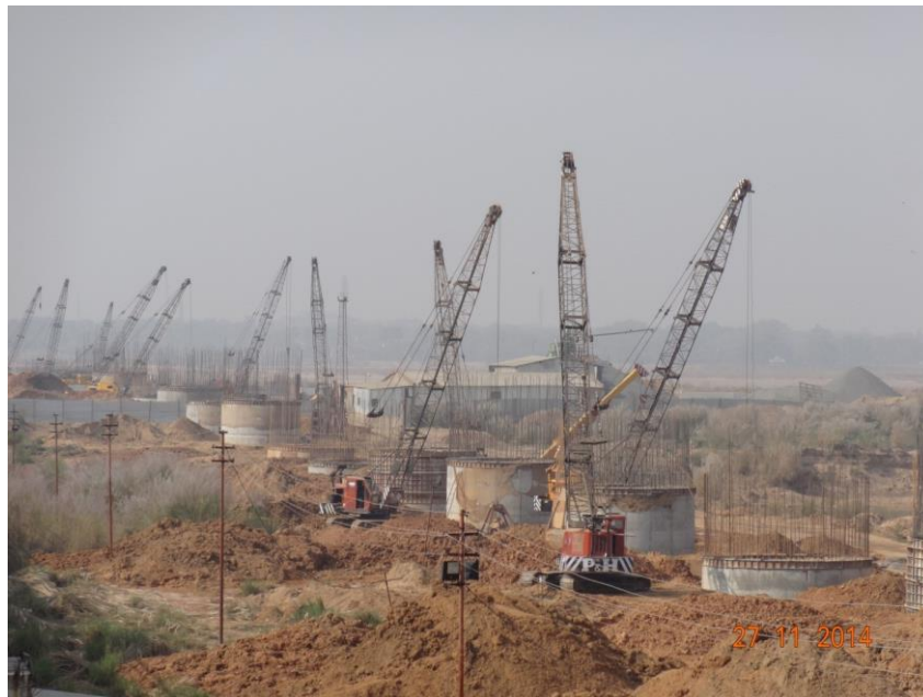
Gambar 4.3 Contoh dokumentasi pelaksanaan pekerjaan fondasi sumuran (DFCCIL, 2014)
