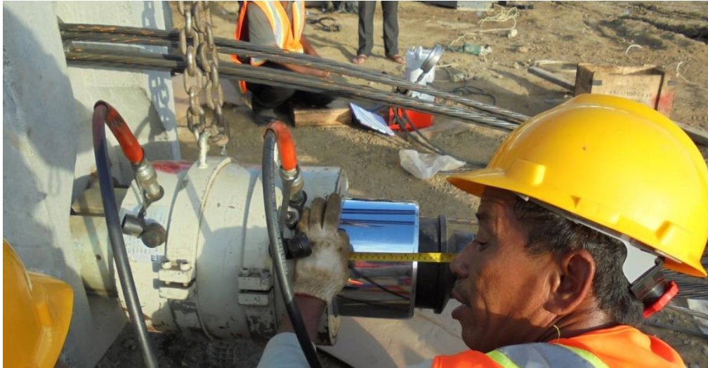
Gambar 6.23 - Pengukuran elongation
