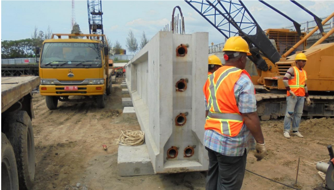
Gambar 6.17 - Penyusunan Gelagar sesuai nomor kode produksi
