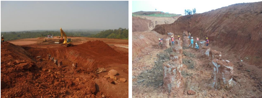
Gambar 5.19 - Pekerjaan galian pilar jembatan
