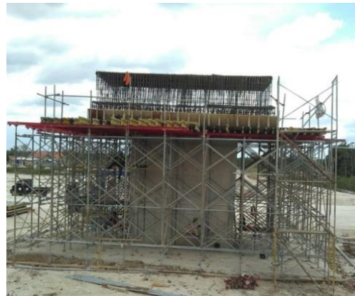
Gambar 5.29 - Pekerjaan bekisting kepala pilar
