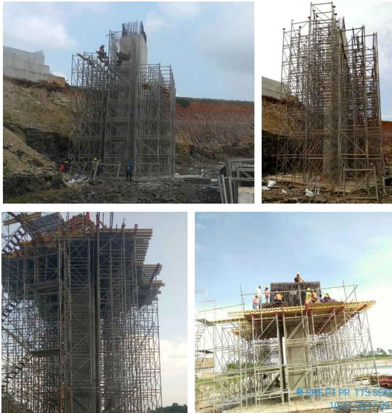
Gambar 5.28 - Pekerjaan penulangan kepala pilar
