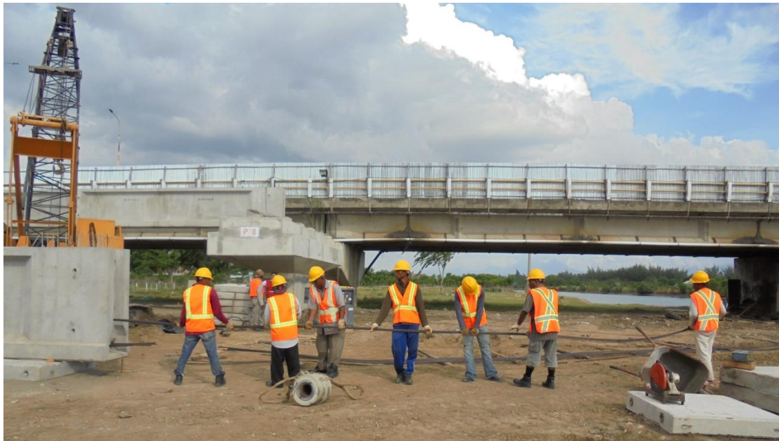
Gambar 6.18 - Memasukkan Strand ke lubang tendon.
