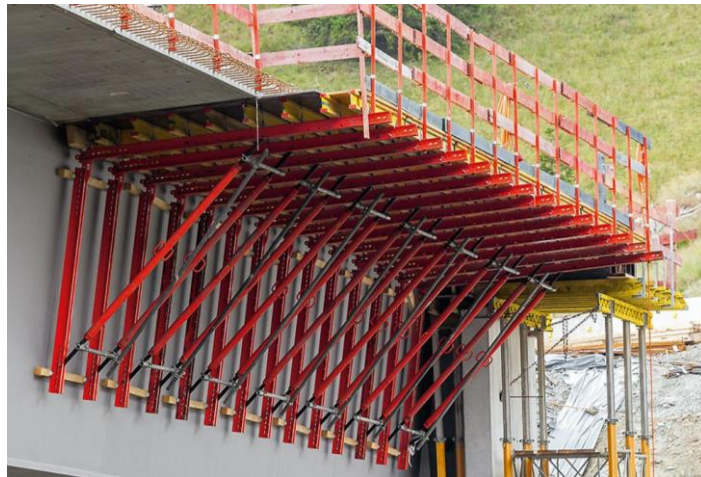
Gambar 3.1- Sistem acuan kantilever
