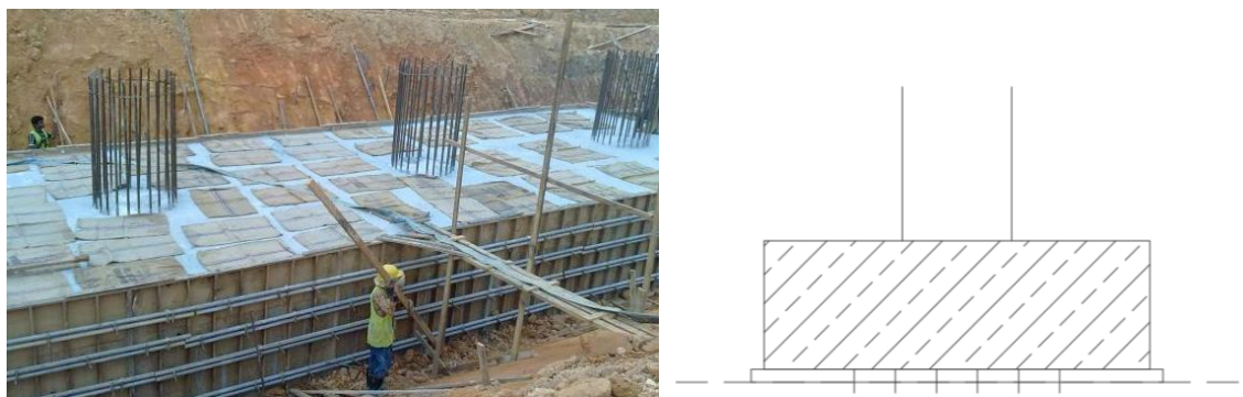
Gambar 5.11 - Pekerjaan curing footing kepala jembatan
