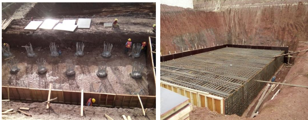
Gambar 5.21 - Pekerjaan bekisting pile cap
