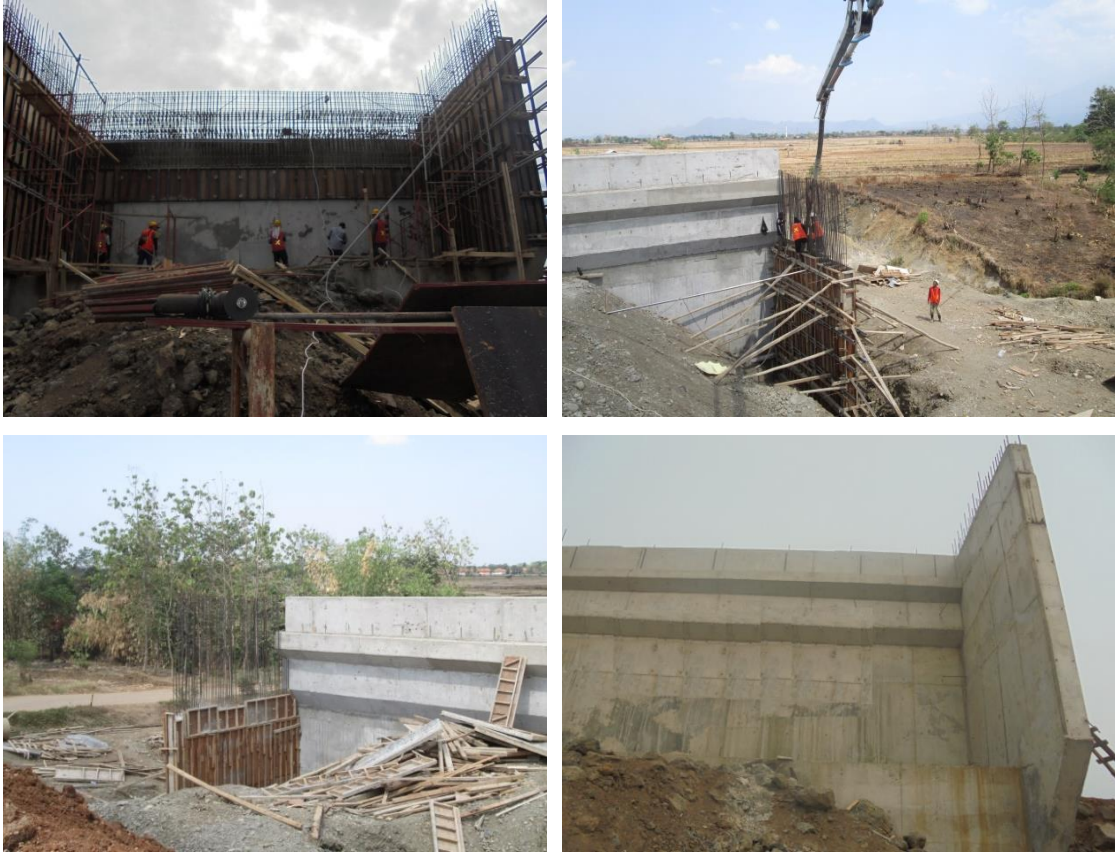
Gambar 5.15 - Pekerjaan wing wall
