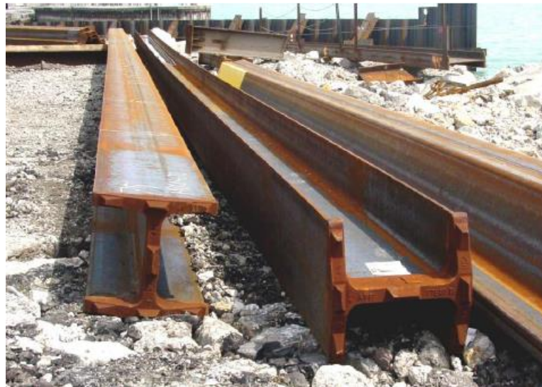
Gambar 4.12 - Fondasi tiang baja profil H (FHWA, 2016)
