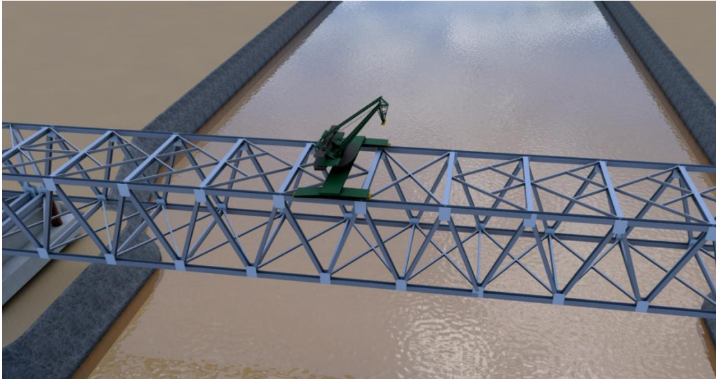
Gambar 6.88 - Perakitan rangka permanen pada tengah bentang terhubung
