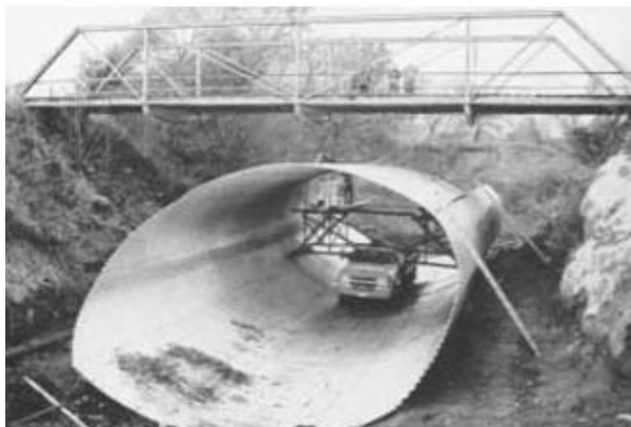
Gambar 6.145 - Perletakan CSP
