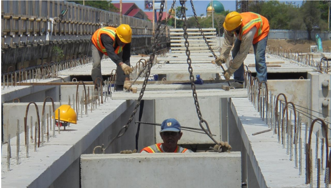
Gambar 6.36 - Pemasangan diafragma dengan Crane
