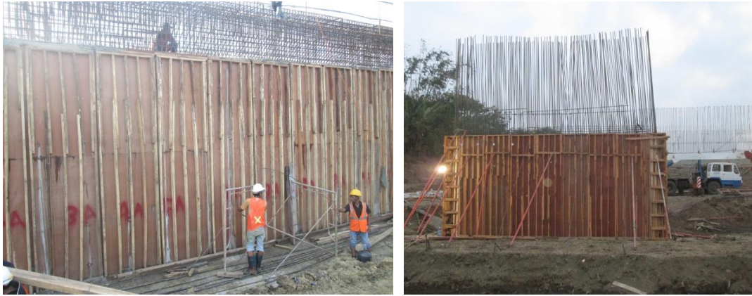
Gambar 5.26 - Pekerjaan bekisting pier kolom
