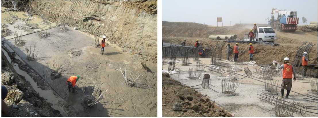
Gambar 5.7 - Lantai kerja pekerjaan abutment
